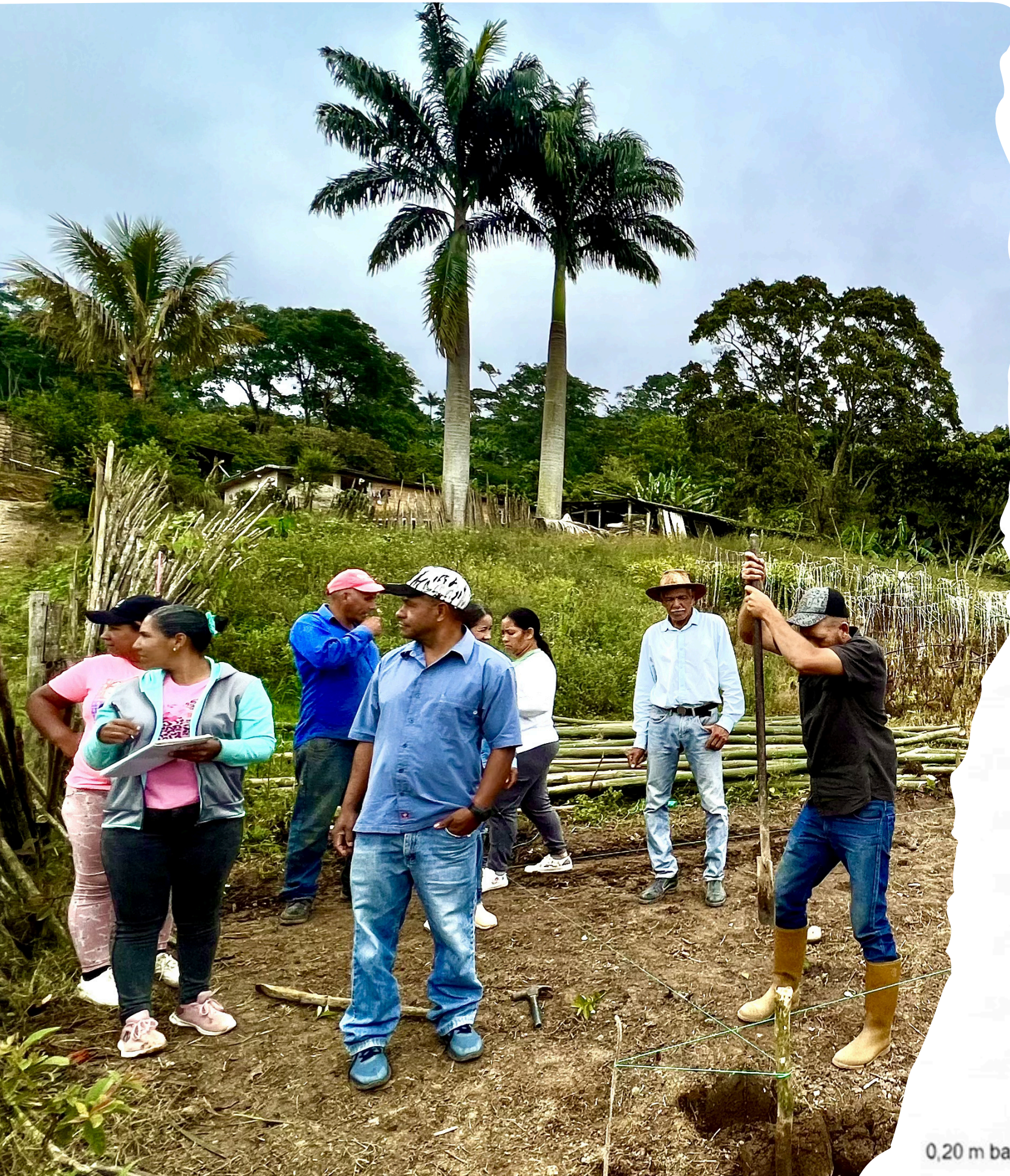
Estructura base para la construcción de un módulo estándar
