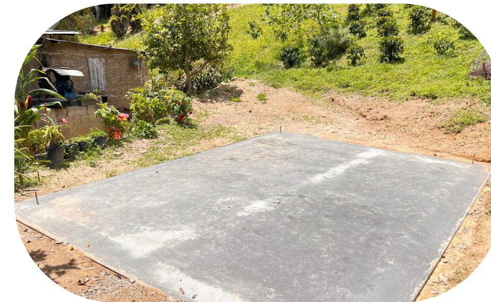
Preparación de losa y piso (Volumen 0,96 m 3 )
